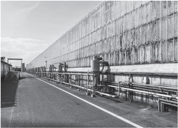
長さ150mのクローズド式処理施設で発酵させる
